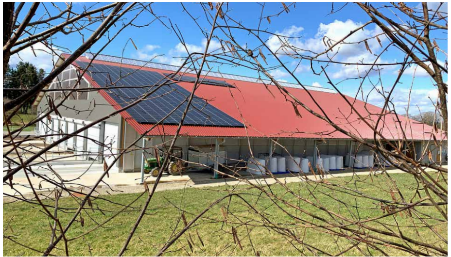
Familie Sailer hat auf dem Dach ihres Milchviehstalls eine PV-Anlage mit 99,6 kW Peak Leistung.
