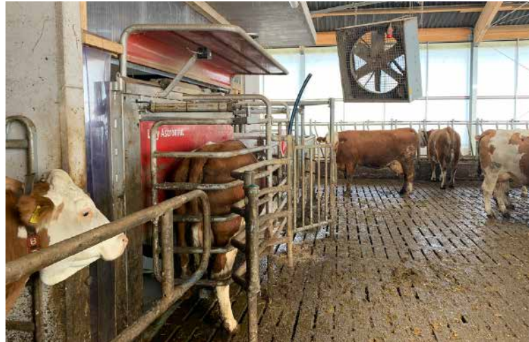
Bei Michael Müller wird auch der Ventilator am Melkroboter gesteuert. Künftig will er das Reinigungswasser für die Roboter mit Eigenstrom erwärmen.
